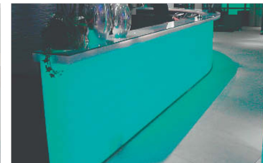
Door te werken met de specifieke samenstelling van de plaat, kan men deze doorschijnend maken, waardoor men met ingewerkte verlichting kan werken
